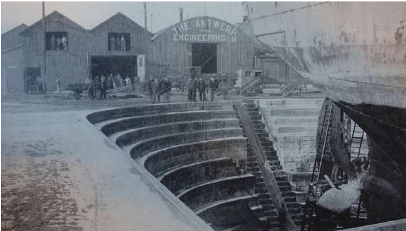
REFERENCE #2, Dry dock 4, Antwerp. Archief Gemeentelijk Havenbedrijf
