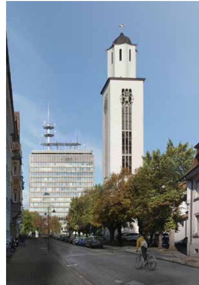
Telekom-Hochhaus old urban fabric
