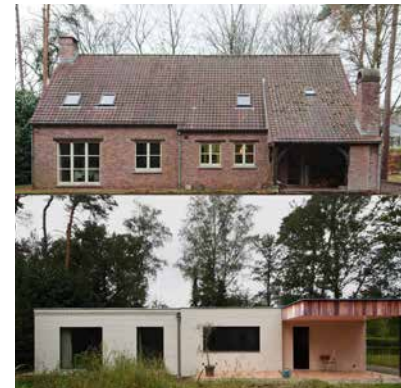
(1) Project Paviljoendreef - Photo IEA
